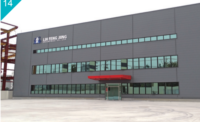
台南立峰井实业边墙，辉彩消光矿纤烤漆钢板 经销 / 荔茂金属 (股) 公司 Siding of Lih Feng Jiing Enterprise Co., Ltd., Tainan, Taiwan Crystallite Silky Pre-Painted Steel Sheet
