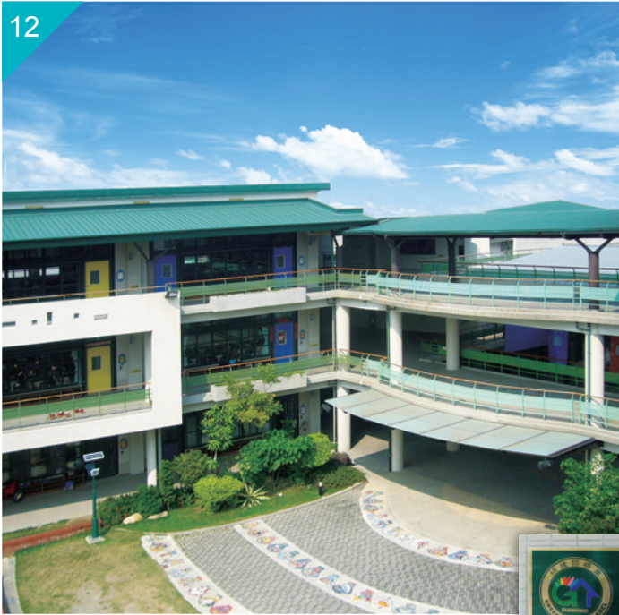
高雄市前镇区红毛港小学屋顶，PVDF 烤漆钢板 *1 经销 / 荔茂金属 (股) 公司 承造 / 将达工程有限公司 Roofing of Kaohsiung Hongmaogang Primary School, Kaohsiung, Taiwan Paint Type: PVDF
