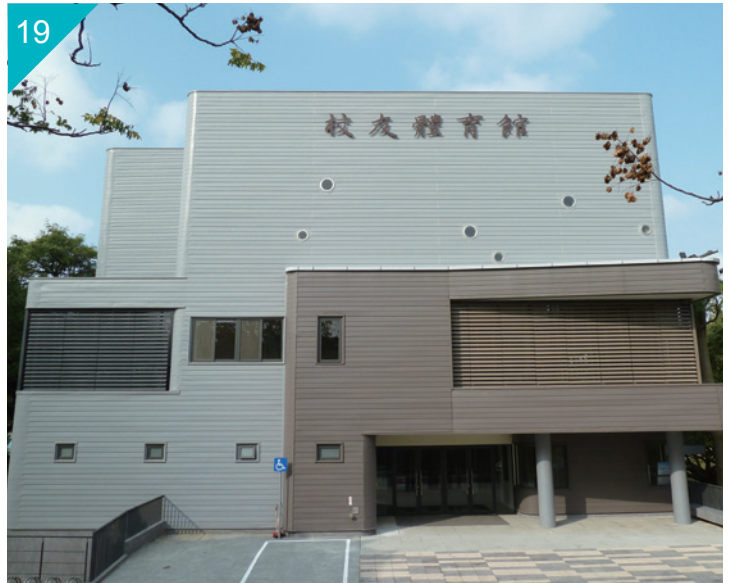
台湾清华大学校友体育馆屋顶 / 侧墙，PVDF 烤漆钢板 经销 / 荔茂金属(股)公司 承造 / 春野工程有限公司 Roofing/Siding of Alumni Gym, National Tsing Hua University, Hsinchu, Taiwan Paint Type: PVDF
