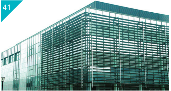
菲尼克斯电气中国公司（南京） 使用焯辉（中国）PVDF 烤漆钢板 承造 / 士兴钢结构有限公司 Phoenix Contact (China) Co., Ltd., Nanjing, China Paint Type: PVDF
