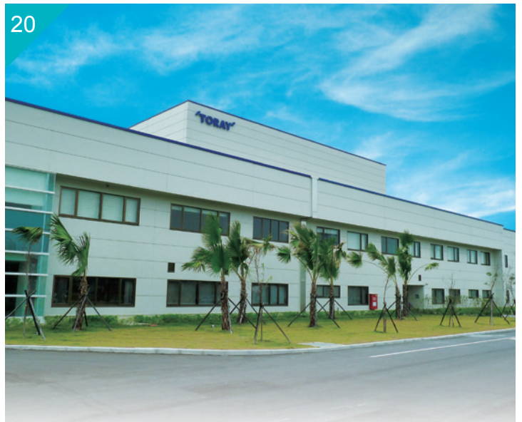
高雄市东丽尖端薄膜厂房，2C 洁能烤漆钢板 经销 / 荔茂金属(股)公司 承造 / 万里钢品(股)公司 Toray Advanced Film Kaohsiung Co., Ltd., Kaohsiung, Taiwan Paint Type: SMP Clean ColorCool
