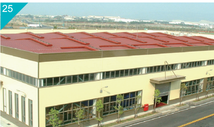
高雄市光阳工业(股)公司屋顶，SMP 烤漆钢板 Roofing of Kwang Yang Motor Co., Ltd., Kaohsiung, Taiwan Paint Type: SMP
