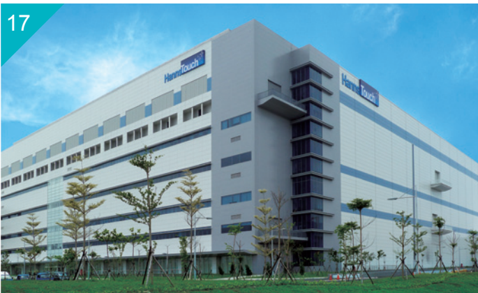
台南和鑫光电(股)公司 - 南科厂屋顶 / 外墙，PVDF 烤漆钢板 经销 / 荔茂金属(股)公司，承造 / 圆加有限公司 Roofing/Siding of HannsTouch Solution Incorporated--Tainan Feb 2, Tainan, Taiwan Paint Type: PVDF
